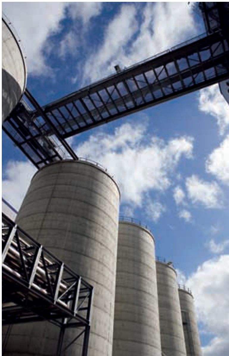
Rohstoff: Tausende Tonnen Getreide in den acht gigantischen Silos der Schwedter Bioethanol-Anlage federn die Nachschubkette ab
