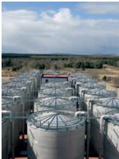
Fermenter: In jedem der 20 Fermenter gären 10 Kubikmeter Maische zwei Tage lang
